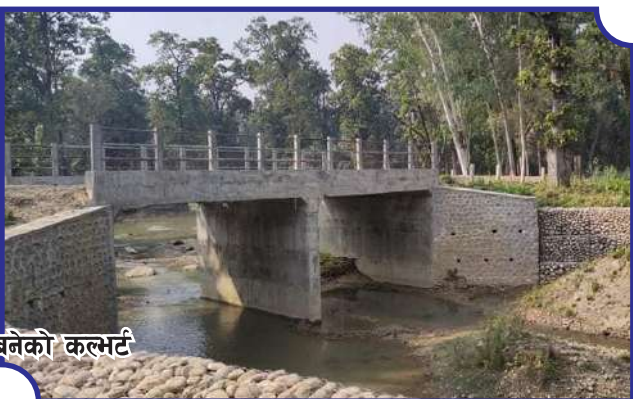
वडा नं. १ को तटबन्धन तथा वडा नं. ३ को कल्भर्ट सहितको नाला
